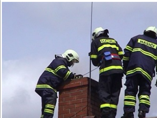
Zásah, zahoření kominového tělesa
